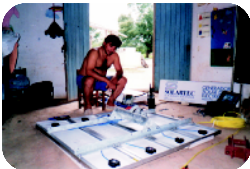
Montaje paneles solares (con recursos propios, APA) para la planta compacta en Tartagal
