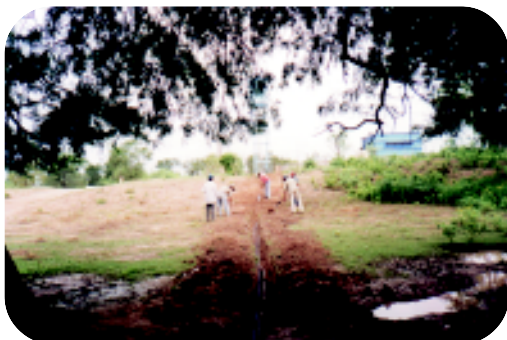
Instalación de cañerías de impulsión en Tartagal. Recursos propios APA.
