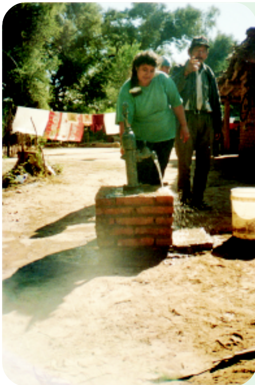
Perforación en la casa del Sr. Torres (Tres Pozos)
