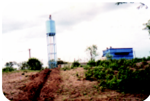
Instalación de cañerías de impulsión en Tartagal. Recursos propios APA.
