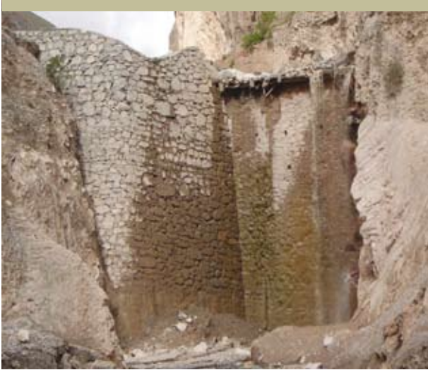
Muros laterales de protección del punto fijo del río Milmahuasi, Iruya, provincia de Salta, Argentina
