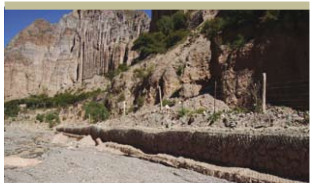
Nivel del lecho y defensas marginales del río Colanzulí luego de la crecida del año 2006
