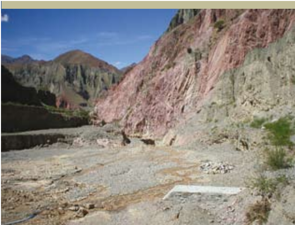
Vista general de los muros transversales aguas arriba del punto fijo del río Colanzulí, Iruya, provincia de Salta, Argentina
