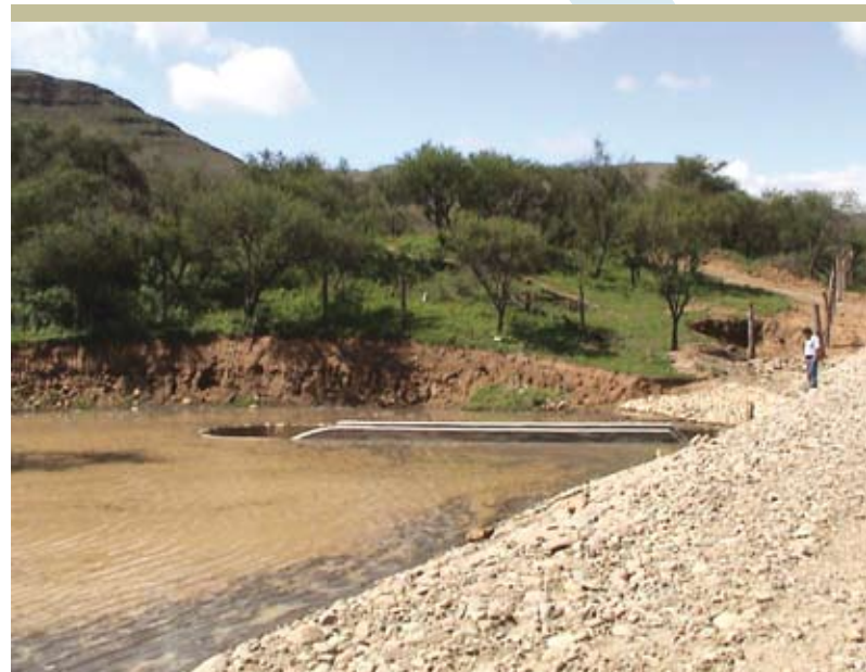
Dique de tierra en el sector Churquis, subcuenca del río Mena, Bolivia
