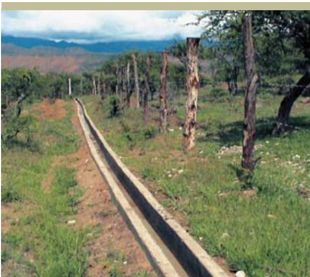
Cerramiento y canal de riego revestido cuenca río Santa Ana, Bolivia
