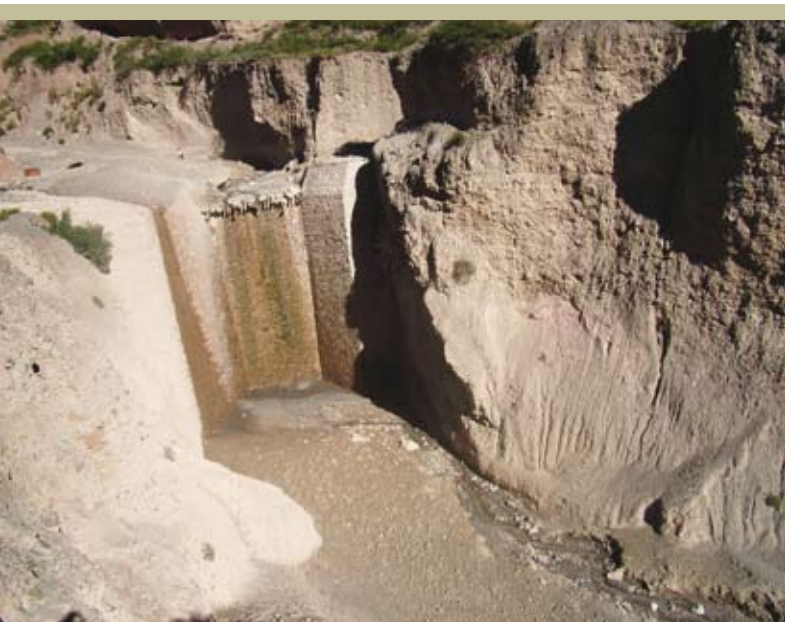
Muro de control de punto fijo en el río Milmahuasi, Iruya, provincia de Salta, Argentina
