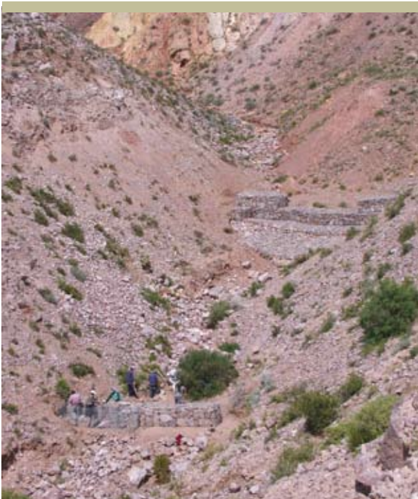
Muro de gaviones en el pedemonte de Tilcara, provincia de Jujuy, Argentina
