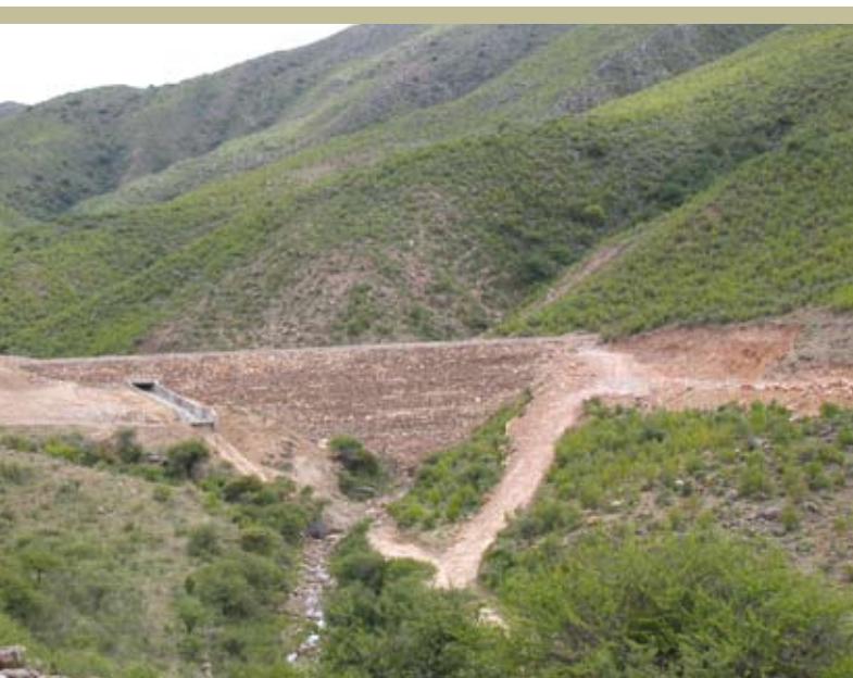
Presa de Enrocado en la cuenca del río Tolomosa, Bolivia
