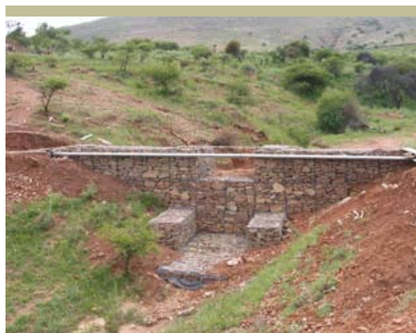
Dique de gaviones en el área de San Jacinto, Bolivia
