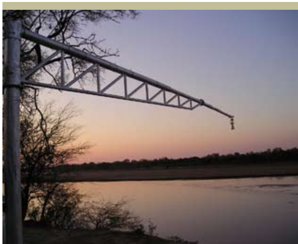
Estación remota El Sauzalito, de la red hidrometeorológica, Argentina
