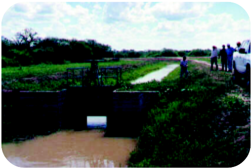
Canal B. Witte (Formosa) que conduce agua del Río Bermejo desde la Victoria a Pozo del Tigre.
