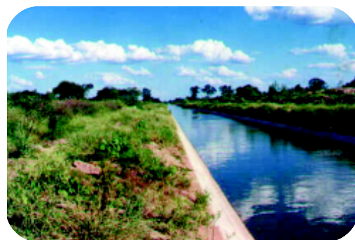
Canal revestido en formosa que conduce agua desde Laguna Yema a Las Lomitas
