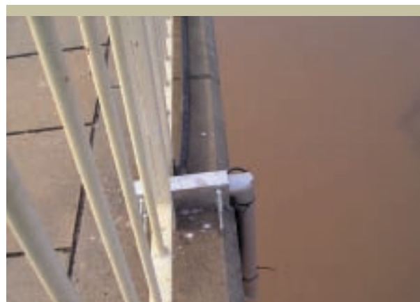
Ubicación del sensor de radar en el Puente de Puerto Lavalle, Argentina
