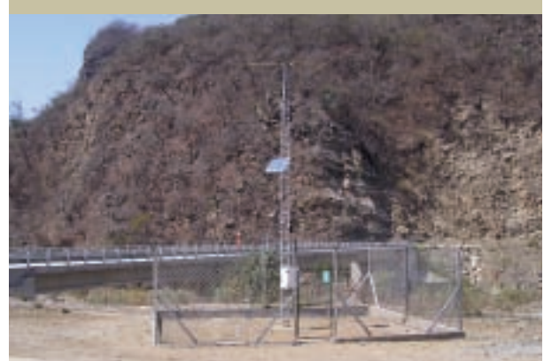
Antena transmisión, cerco perimetral y panel solar de la estación Alarache, Bolivia
