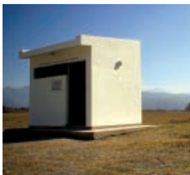
Estación central de comunicaciones (ECC), Salta, Argentina.
