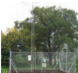
Cerca perimetral, antena, pluviómetro y datalogger en la estación Caimancito, Argentina
